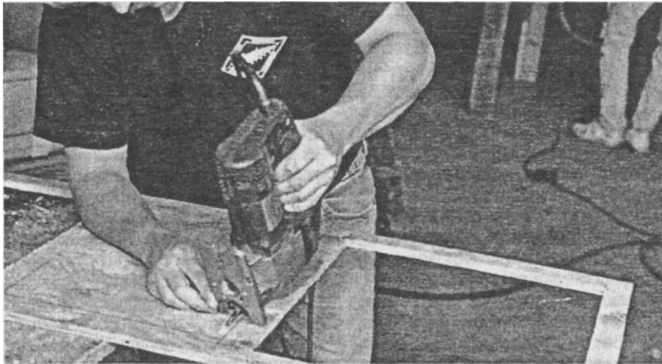
Барри вырезает переднюю стенку шкафа. Обратите внимание, он делает прорез ножовкой. Попрактикуйте этот прорез сначала на каком-нибудь ненужном куске. Если вы не большой специалист в обращении с ножовкой, просверлите сначала дырку и работайте оттуда.
