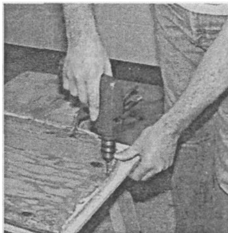
На этом этапе разметьте все отверстия. Разместить их потом будет очень сложно, особенно это касается места крепления для сиденья.
